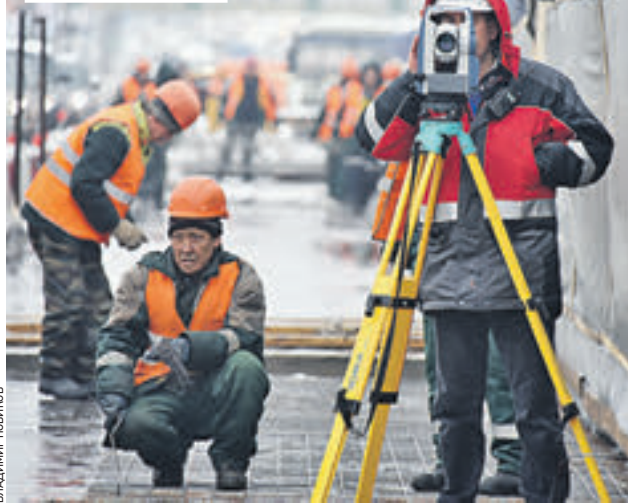
2 марта 2016 года. Ход реконструкции Нагатинского моста
