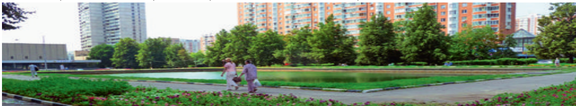
Отремонтирована чаша пруда на площади им. Академика Вишневого.
