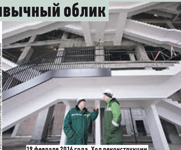
19 февраля 2016 года. Ход реконструкции стадиона «Лужники»
