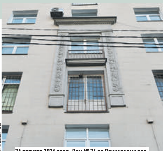
26 августа 2016 года. Дом № 24 по Ленинскому проспекту. Здесь восстановят балкон, а решетку уберут
