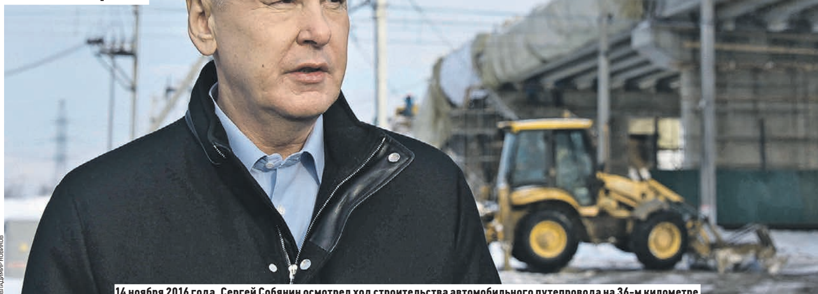
14 ноября 2016 года. Сергей Собянин осмотрел ход строительства автомобильного путепровода на 36-м километре Киевского направления железной дороги в Крекшине. Все работы будут завершены в 2017 году
