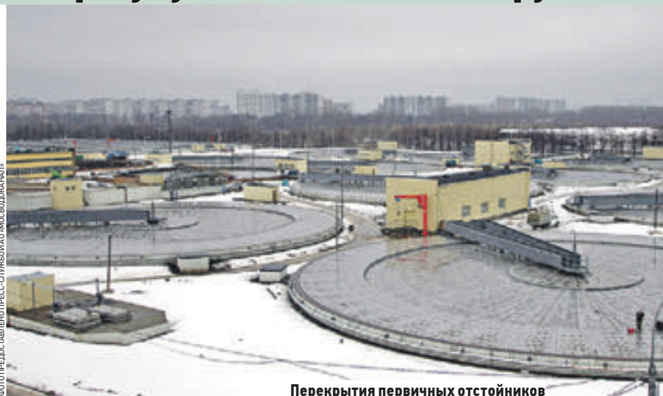
Перекрытия первичных отстойников на Курьяновских очистных сооружениях
