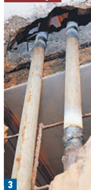
Пятиэтажки обладают целой массой конструктивных особенностей, которые не позволяют провести в них капремонт: конструкции балконов изношены (1), стены разрушаются (2), а трубы и отопление вмонтированы в стены (3)
