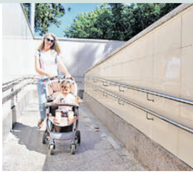
6 августа 2017 года. Яна Кукус с дочкой Ульяной спускается в новый пешеходный переход в Коломенском проезде
