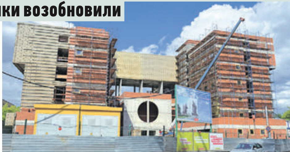
20 июня 2018 года. Сейчас наружная инженерия здания поликлиники выполнена на 90 процентов
