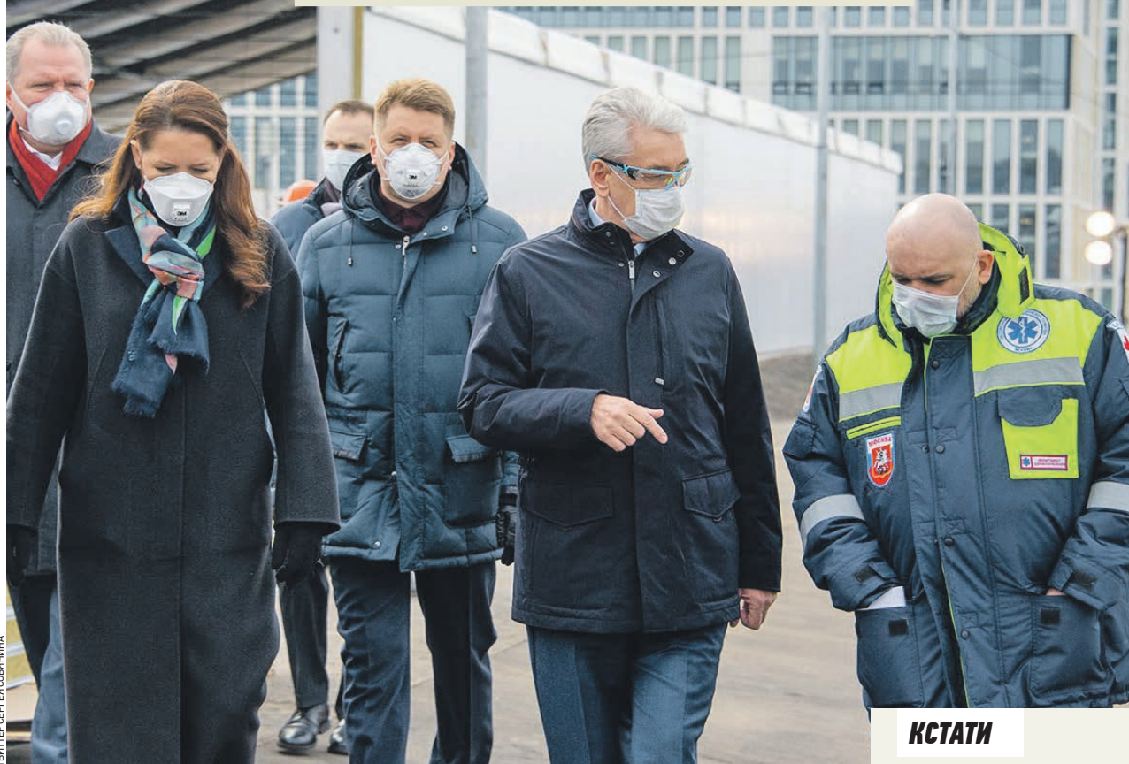
24 апреля 2020 года. Мэр Сергей Собянин (в центре) осмотрел строительство корпусов. Слева от него заммэра по вопросам соцразвития Анастасия Ракова, справа — главврач больницы Денис Проценко
