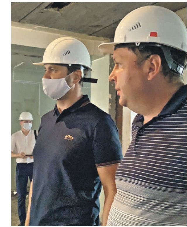
18 августа 2020 года. Депутат Мосгордумы Кирилл Щитов (в центре) осматривает, как идет ремонт в детской поликлинике № 145
