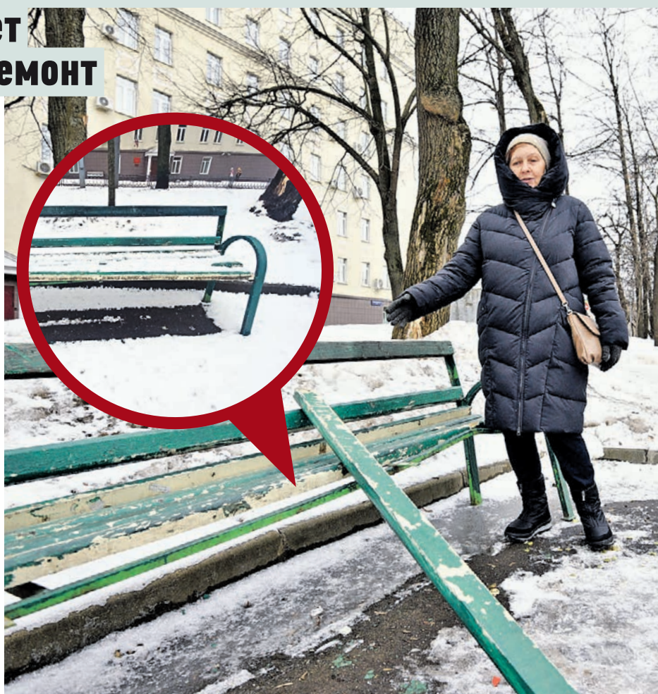
23 марта 2021 года. Жительница района Венера Хабибулина показывает сломанную лавочку в сквере на Каширском проезде. Сейчас доску вернули на место, а позже скамейку приведут в порядок
