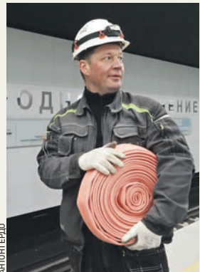
30 марта 2021 года. Монтажник Сергей Давиденко, станция «Народное ополчение»
