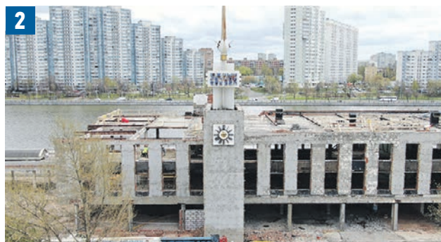
2 Проект реконструкции Южного речного вокзала (1). 26 апреля 2021 года. Работы в здании уже начались (2)
