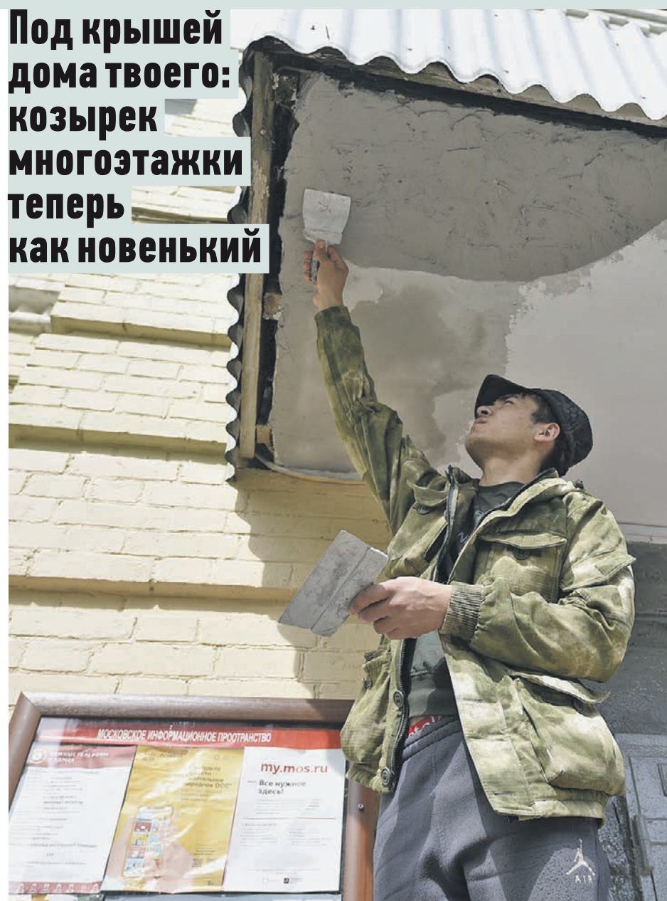
14 мая 2021 года. Сотрудник ГБУ «Жилищник Даниловского района» Сергей Жюнов штукатурит предварительно очищенное место разрушения на козырьке подъезда
