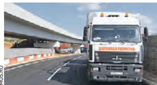
Новый путепровод облегчит передвижение между районами
