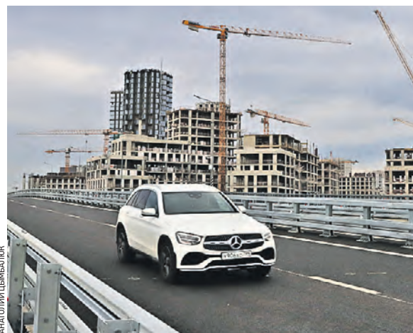
14 августа 2023 года. Движение по новому мосту через затон Новинки открыто
