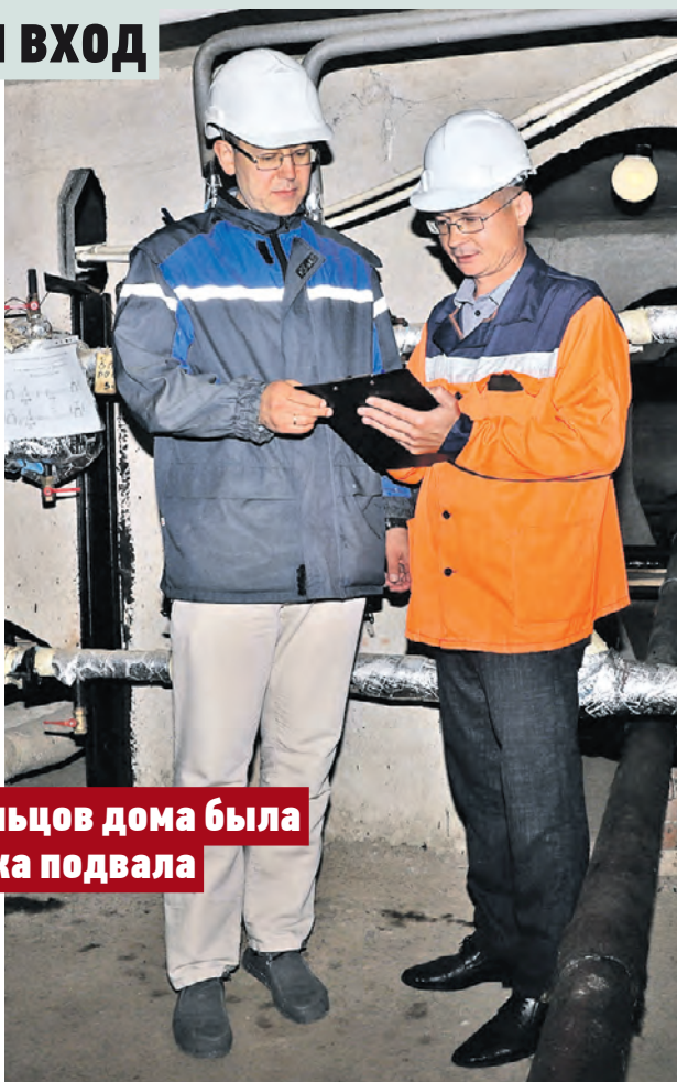
16 августа 2023 года. Ведущий инженер отдела по учету энергоресурсов Павел Варламов вместе с муниципальным депутатом Орехово-Борисова Южного Максимом Демченковым (слева) проверяют подвал жилого дома на Воронежской, 48, корпус 1
