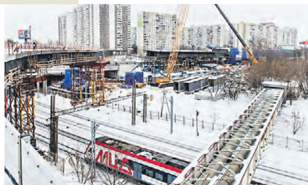
23 января. Строительство эстакады-съезда с Московского скоростного диаметра на Каширское шоссе
