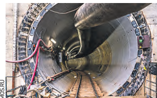
12 октября. Завершилась проходка соединительной ветки в электродепо «Столбово»
