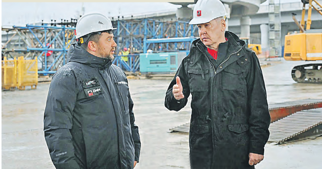
18 ноября. Мэр Москвы Сергей Собянин и директор компании-подрядчика Михаил Григорьев осматривают ход строительства участка МСД
