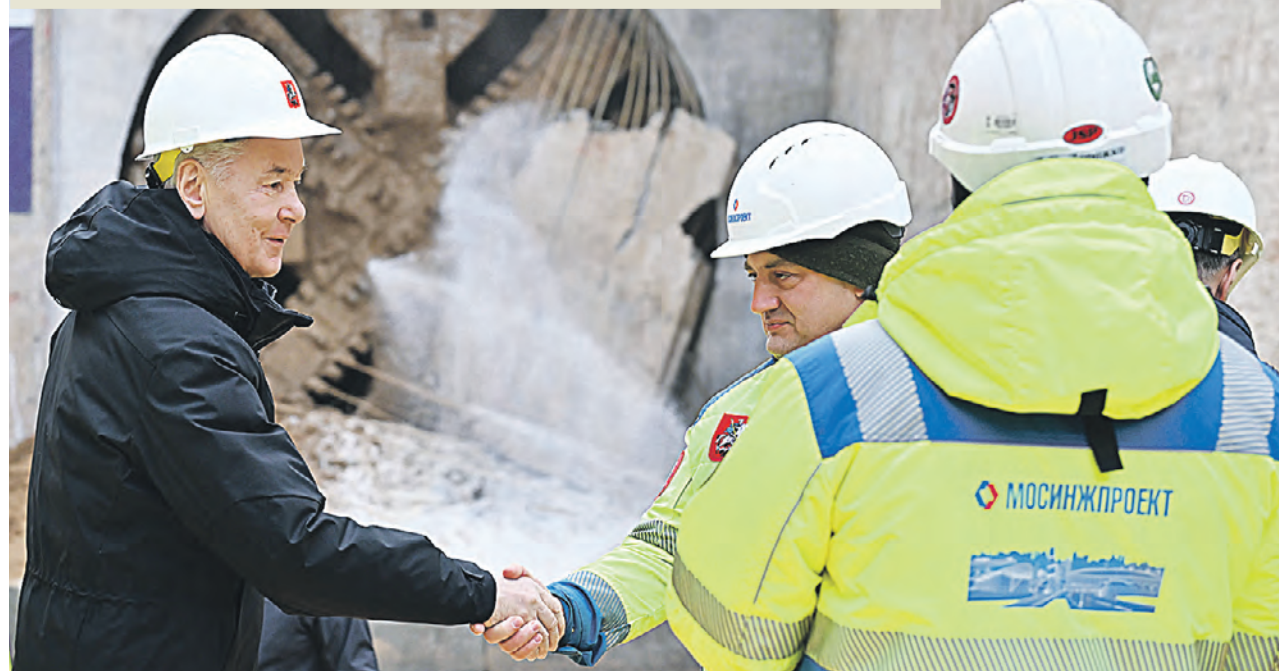
25 ноября. Мэр Москвы Сергей Собянин осмотрел ход работ на строящейся станции «Народное Ополчение» Рублево-Архангельской линии
